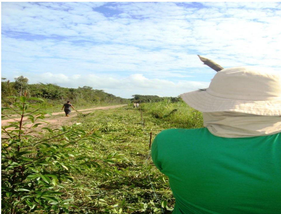
Foto 16: Balizamento e piqueteamento do local, Pingo D'Água, Curuçá, PA. Mai. 2016.
