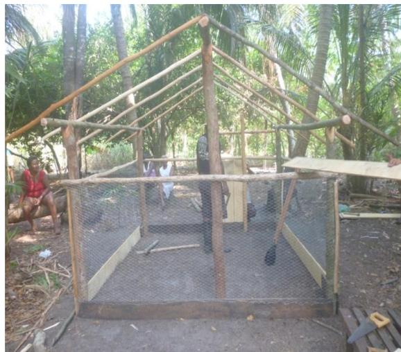
**Imagem 06: Instalação da tela, em volta da estrutura do galinheiro.**
