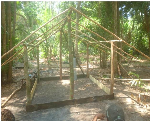
**Imagem 05: Construção com Madeira com forma cilíndrica.**
